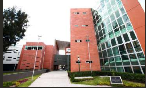
PROYECTO: CENTROS UNIVERSITARIOS CUSH AÑO: 2018 - 2021 SERVICIO: GERENCIA DE OBRA
