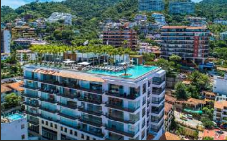
PROYECTO: PIER 57 UBICACIÓN: PUERTO VALLARTA AÑO: 2017 - 2018 SERVICIO: GERENCIA DE OBRA
